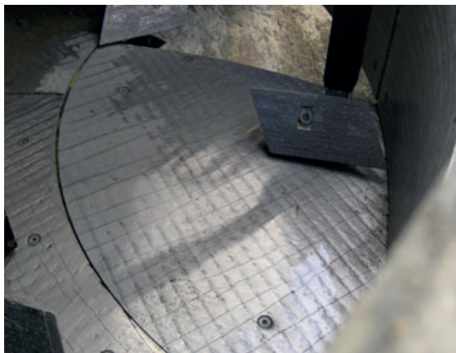
Kein ersichtlicher Verschleiß nach der Produktion von 55.000 m 3 Beton
