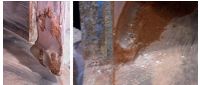
Anhaftungen auf Grund von verschlissenen Bodenwandabstreifer
