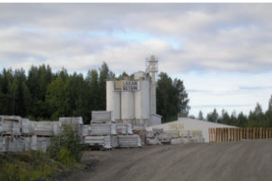
Betonwerk von Lakan Betoni im finnischen Joensuu
